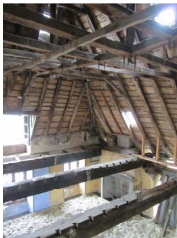
Plancher supprimé 2 ème étage
