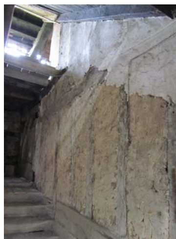
Mur de refend sur cage d'escalier
