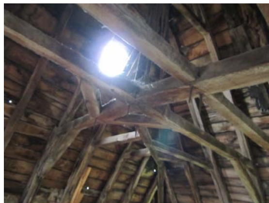
Vue de détail sur les entrails rehaussés
