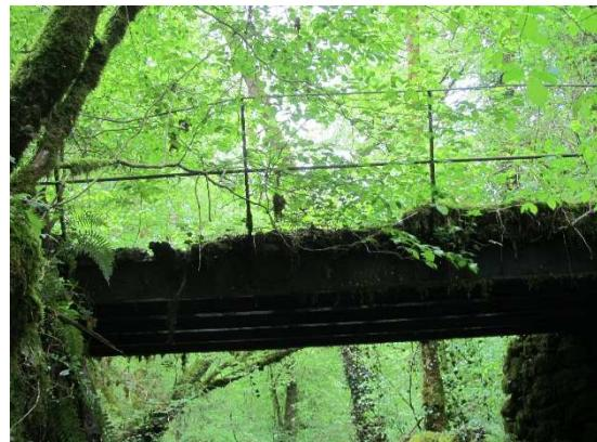
*Tablier – les fers sont à vérifier (remplacement probable) et les planches à changer. Le garde-corps est également à restaurer.*
