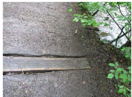
*Chaussée - Les planches sont à remplacer (des remplacements partiels ont déjà été effectués)*
