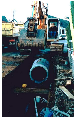
Assainissement, préparation réseaux et terrassement.
