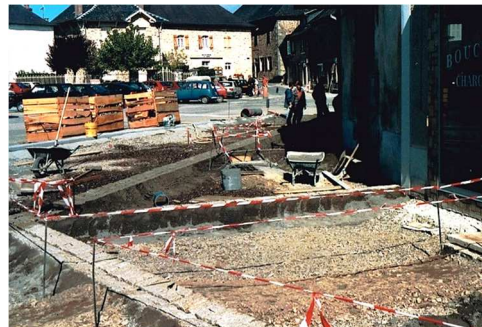
Assainissement, préparation réseaux et terrassement.
