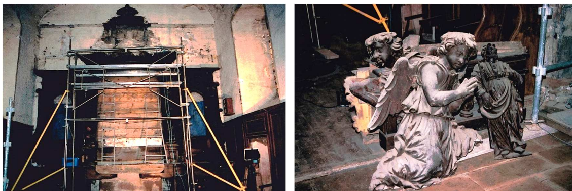
Démontage du retable pièce par pièce et transport en atelier pour restauration
